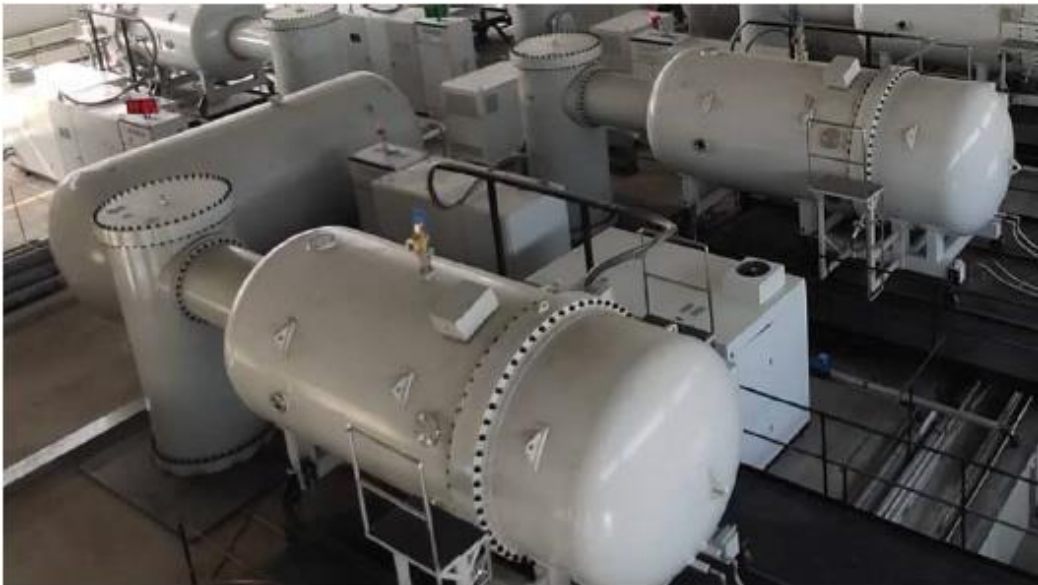
图 2-7 卧式加速器主体钢筒图
