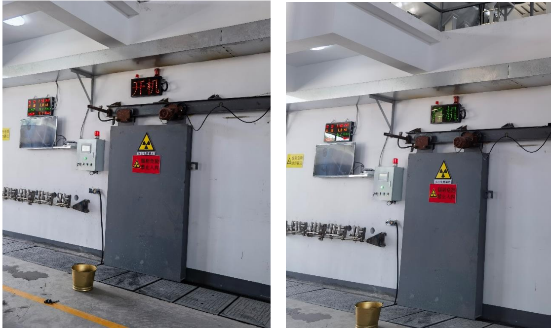
图 4-1 至图 4-11 为部分防护和环保措施落实情况图：
